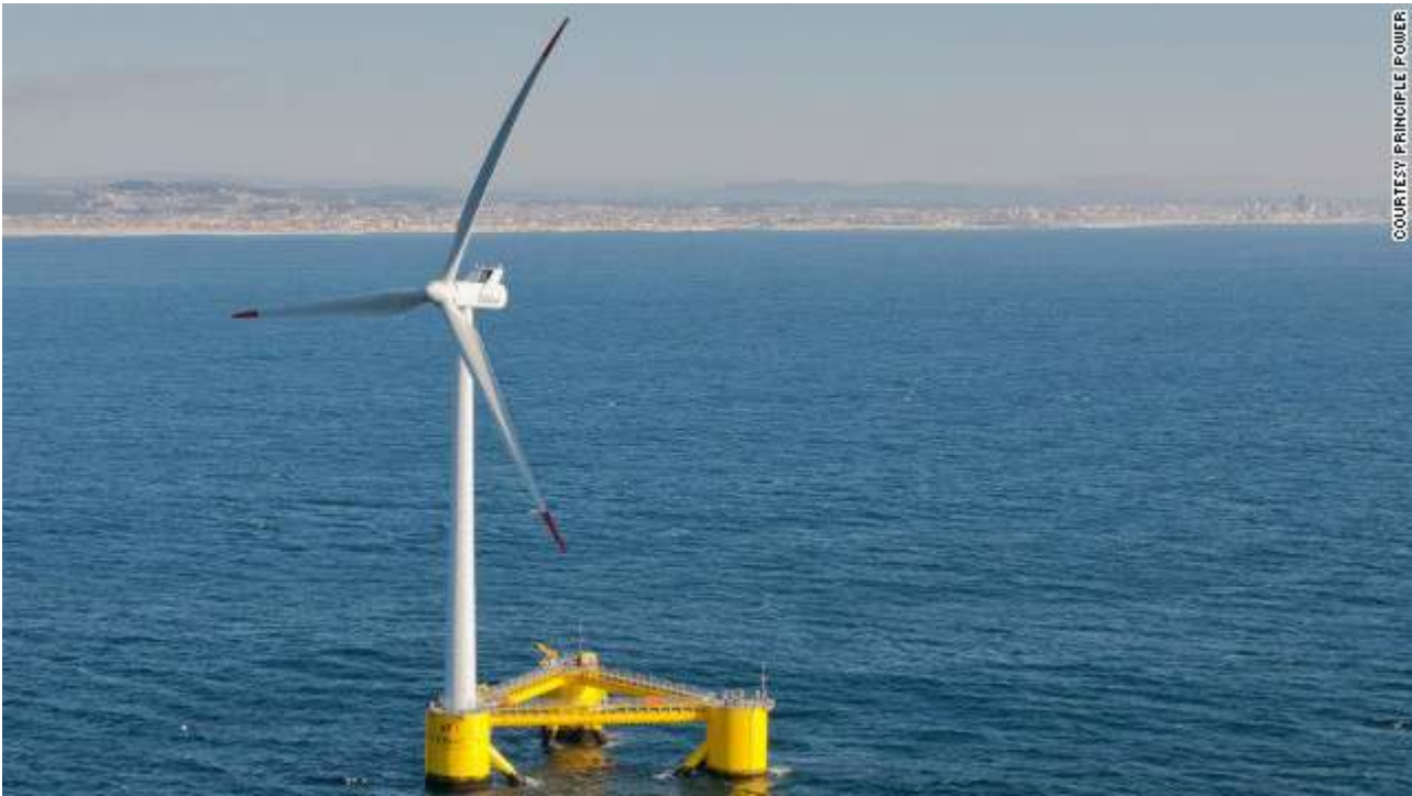
Prototipo WindFloat con turbine Vestas 80, nel sito d'Aguçadoura(Portogallo) ancorato su un fondale di 50 m
